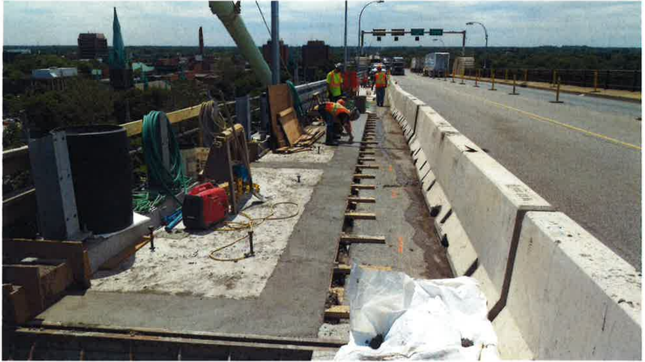
Precast panels 14, 15 & 16 concrete pour
